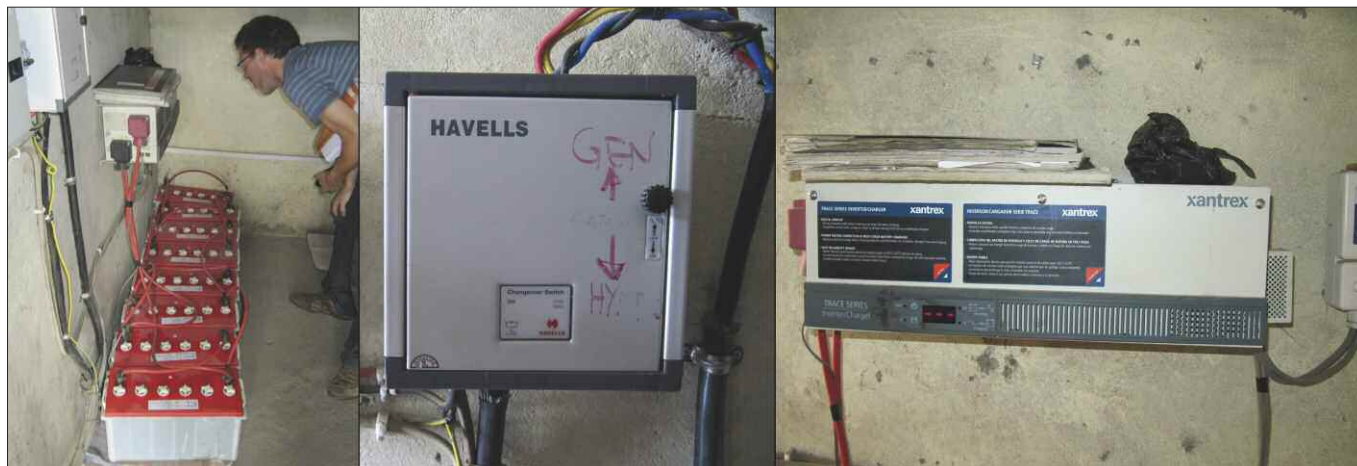
Figura 4 Sistema di accumulo centrale – Interruttore manuale – Convertitore elettronico bidirezionale.
