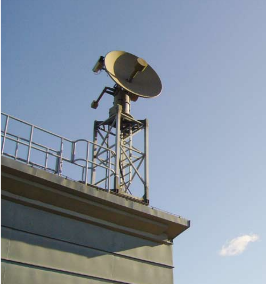
Radar impiegato a Lund per il monitoraggio dell'avifauna migratrice
