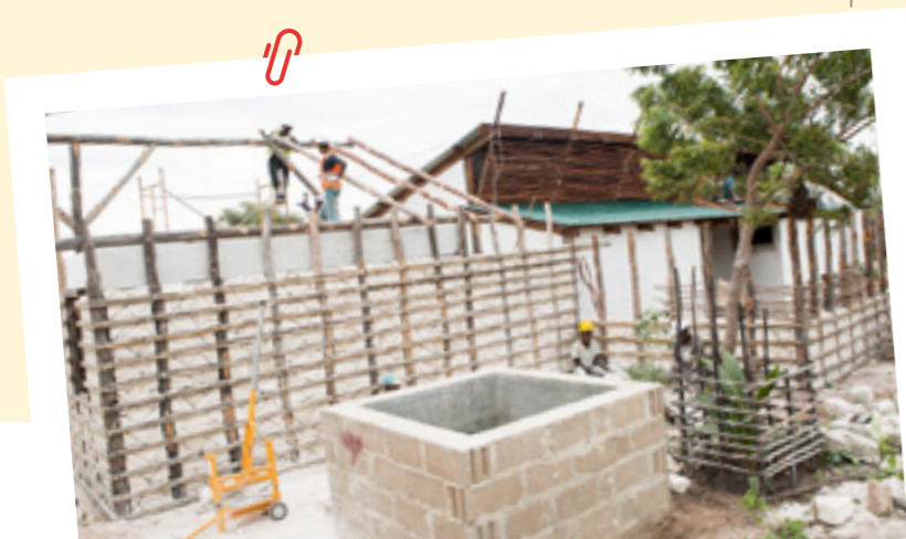
Ecocentro di Ibo, lavori in corso
